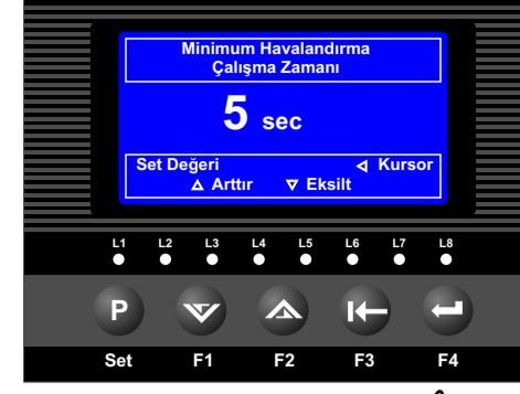
Minimum Havalandırma Çalışma Zamanı
